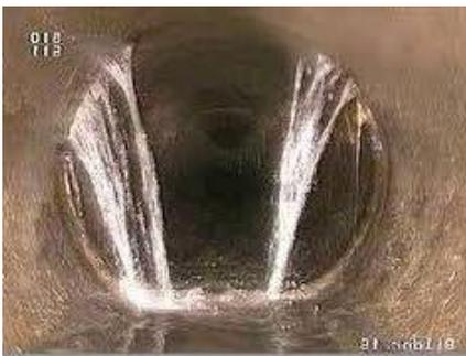
**Fehlanschluss an Versickerungsanlage** – Grundwasserverschmutzung!
