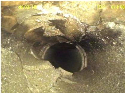
**Wurzeleinwuchs** – das Abwasser wird nicht mehr abfließen und in Keller zurück stauen.
