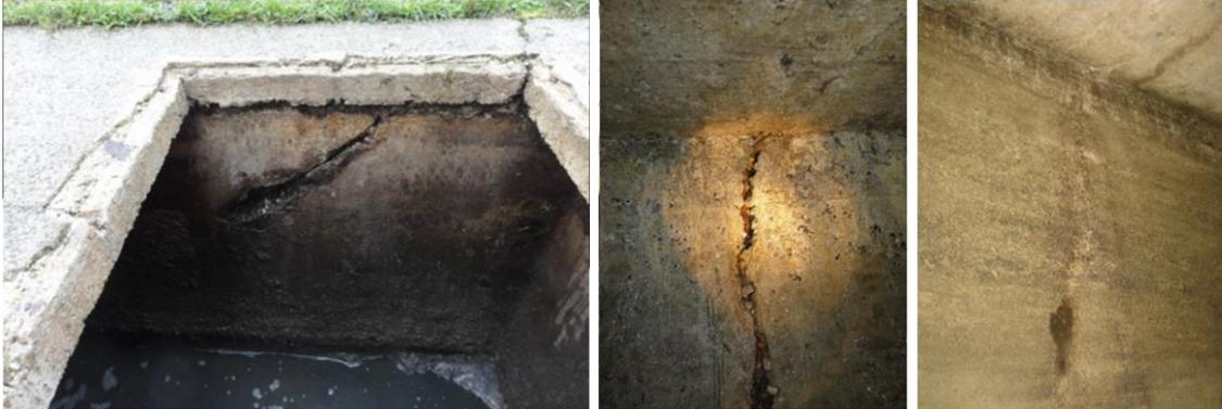
**Abplatzungen** – die Gülle greift Armierung und Beton an – Dichtheit und Statik ist nicht mehr gewährleistet.
