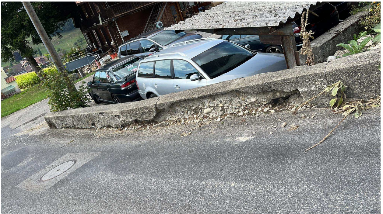
▪ Abbildung 1 Stützmauer Allmend 31
